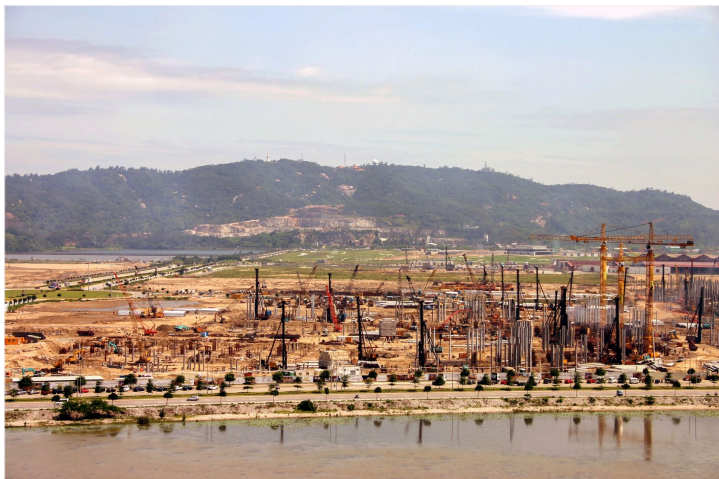
回歸後澳門博彩業蓬勃興起，路氹城區隨之展開了翻天覆地的填海與建設，金光大道的大輪廓正逐步顯現。張振鴻攝。
